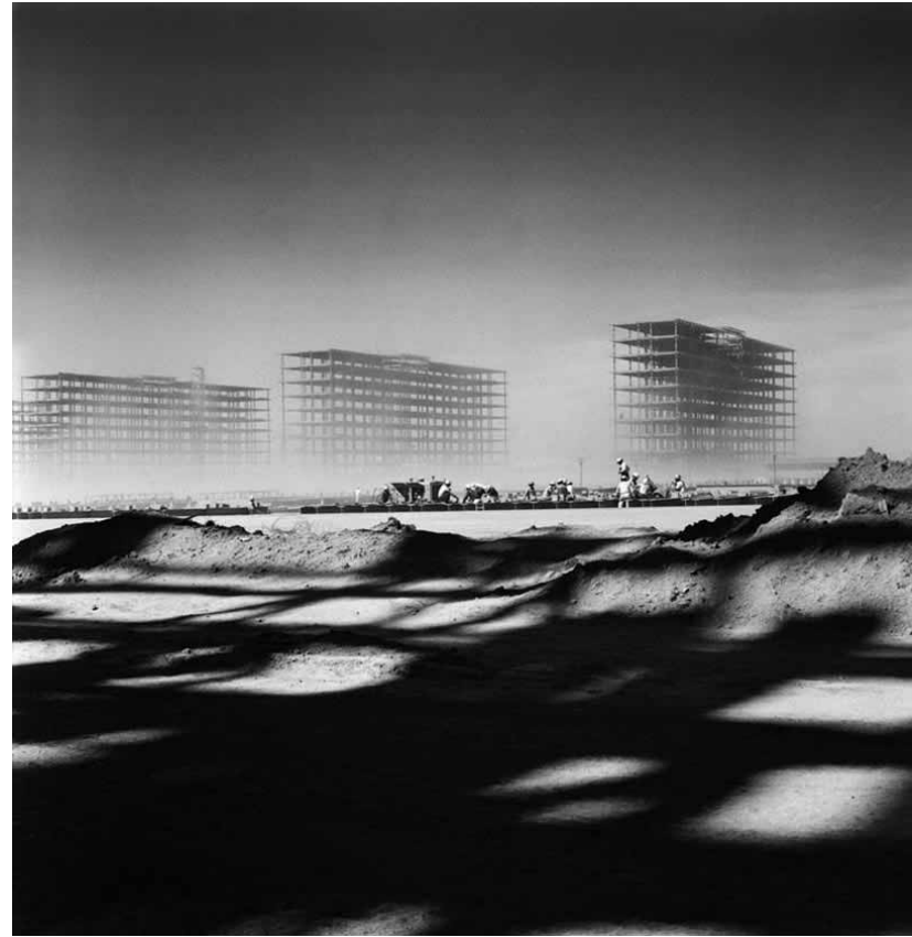
Marcel Gautherot, Construindo Brasília, 1958.
